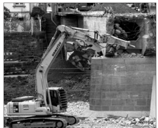
Bamberg: Brückenabriss und Busverkehr – ab Seite 39
